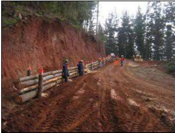
Construcción de empalizada con cuadrilla de camino
