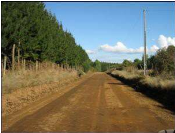
Perfilado de camino con Motoniveladora
