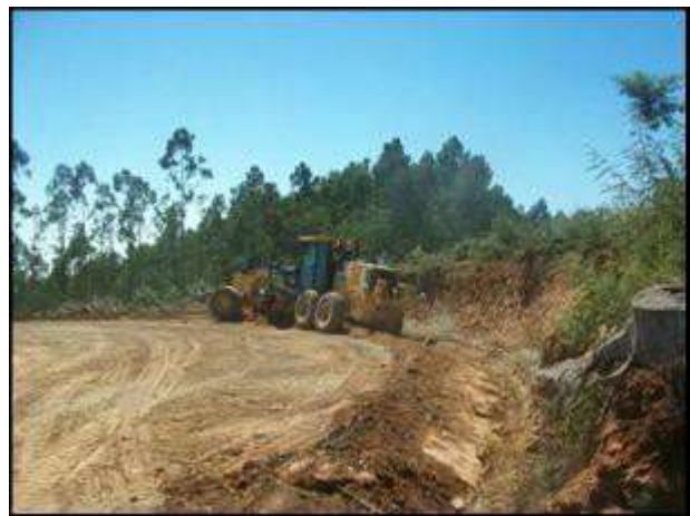
Camino Perfilado y Cunetas reconformadas
