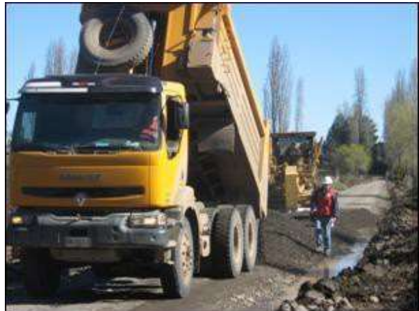
Recargue de Camino con Material pétreo
