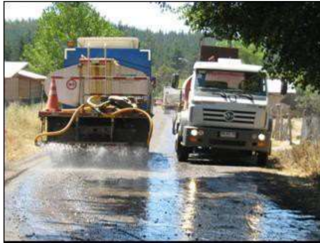
Aplicación de Supresor de polvo químico con camión aljibe
