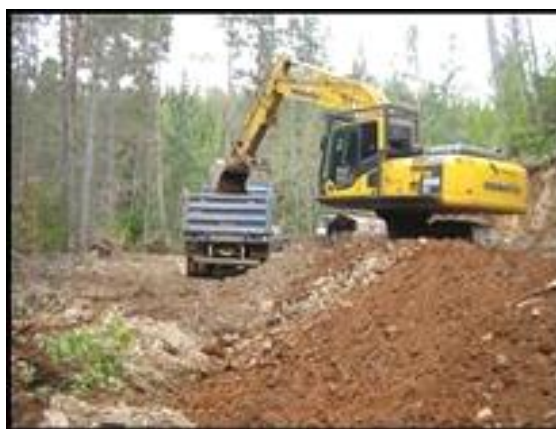
Movimiento de tierra con carguío a camión
